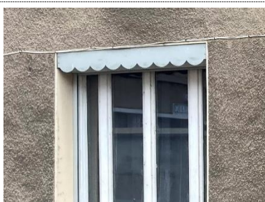
Exemples de lambrequin sous le linteau d'une fenêtre
