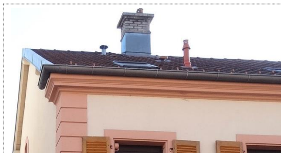
Exemple de corniche moulurée
