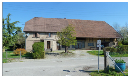
Maison agricole rue de l'Ancienne église
