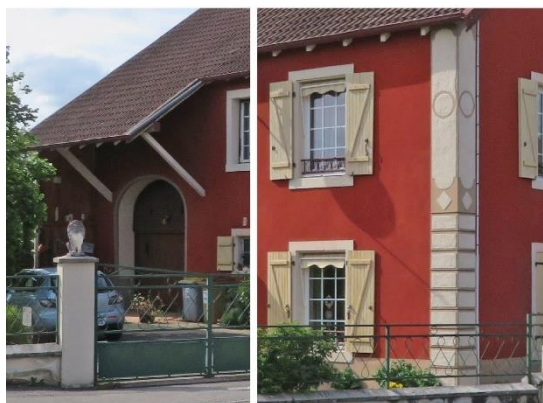
Détails de façade
