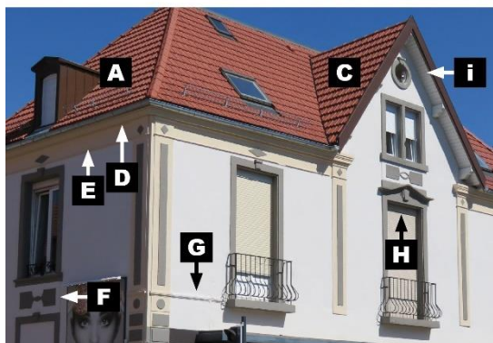
Détails de façade
