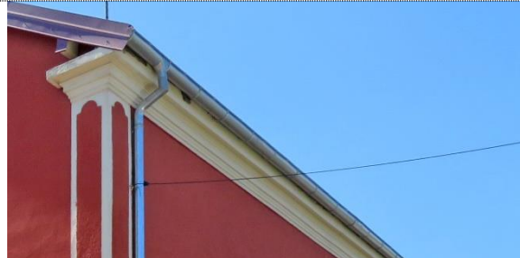
Exemple de corniche à retournement d'angle
