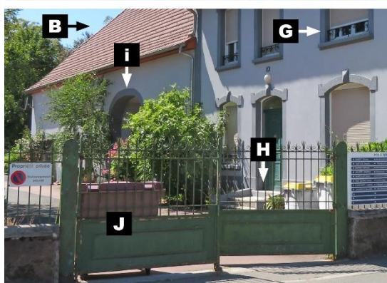
Détails de façade
