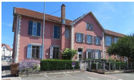
Façade Ouest (arrière)
