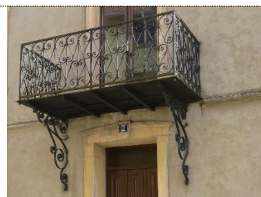
Consoles en fer forgé soutenant un balcon
