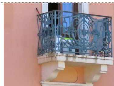
Consoles en pierre soutenant un balcon
