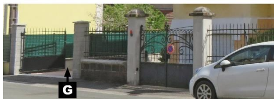
Détails de façade
