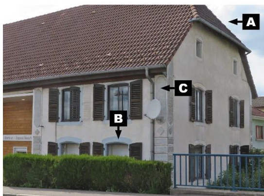
Détails de façade
