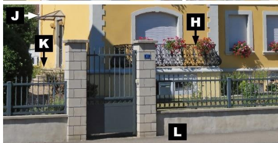
Détail de façade et clôture
