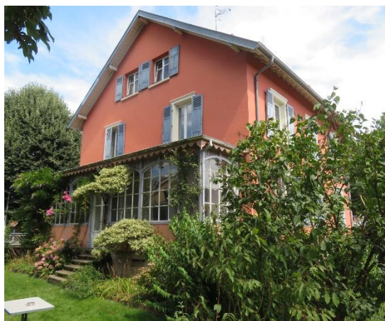
Façade sud-ouest côté jardin
