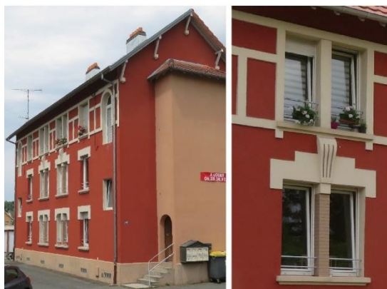
Façades et détail de fenêtres jumelées
