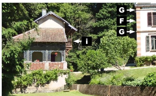
Détails de façade et dépendance
