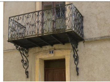
Consoles en fer forgé soutenant un balcon
