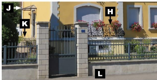
Détail de façade et clôture
