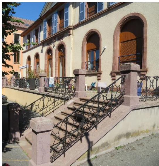
Détail de façade
