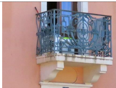
Consoles en pierre soutenant un balcon
