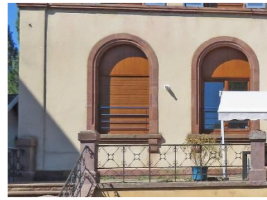
Exemple de baie en plein cintre
