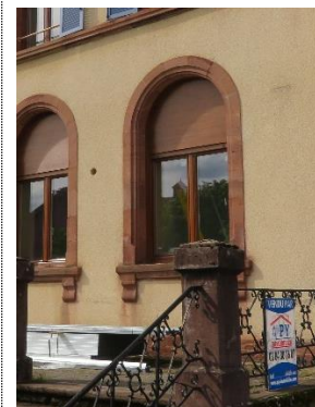
Imposte pleine au-dessus d'une fenêtre
