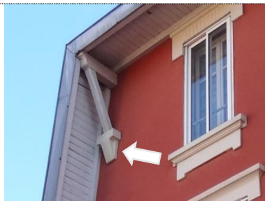
Corbeau soutenant un aisselier
