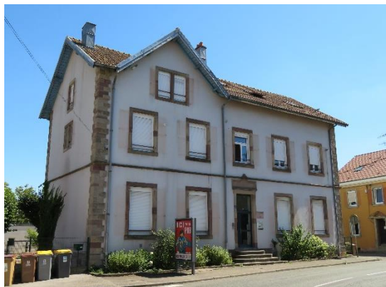
Façade sur rue (Nord-Ouest)
