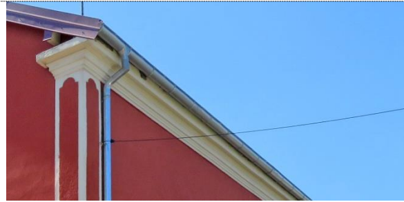
Exemple de corniche à retournement d'angle
