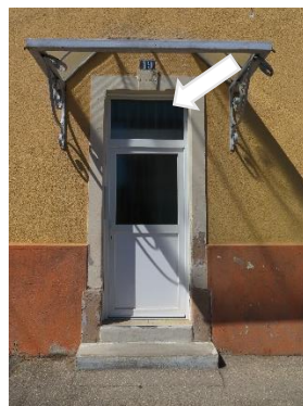
Imposte vitrée au-dessus d'une porte
