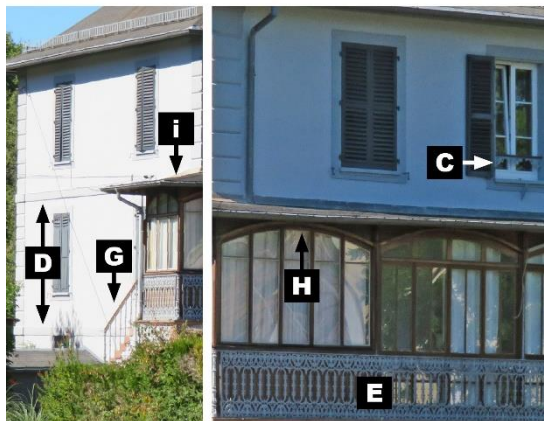
Détails de façade après ravalement (en bas), façade avant ravalement (première photo en haut).
