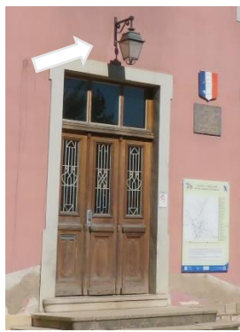
Imposte vitrée au-dessus d'une porte
