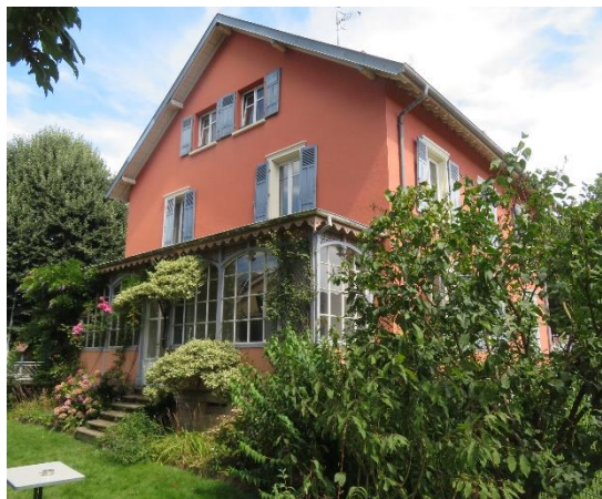
Façade sud-ouest côté jardin
