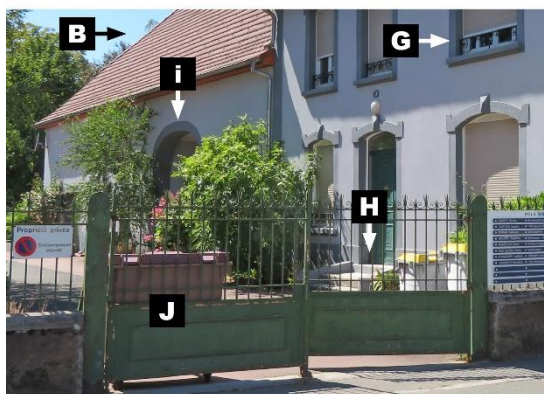
Détails de façade
