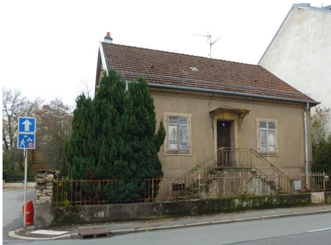
2, angle rue Carnot et rue Pasteur
