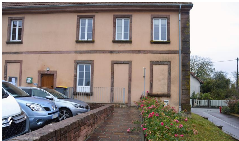
Le chantier de l'année sera la finalisation de l'accessibilité de la mairie, déjà dotée d'une rampe d'accès extérieure.
